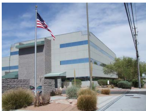
写真1 Clark 郡 NJC の建物
